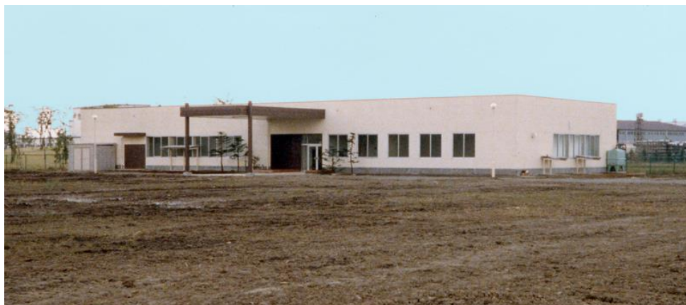
久喜工場第一棟完成 (昭和55年1月)
